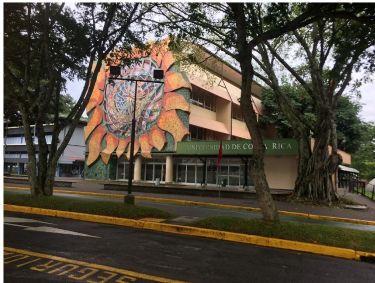
Das Gebäude der „Estudios Generales“ an der UCR
