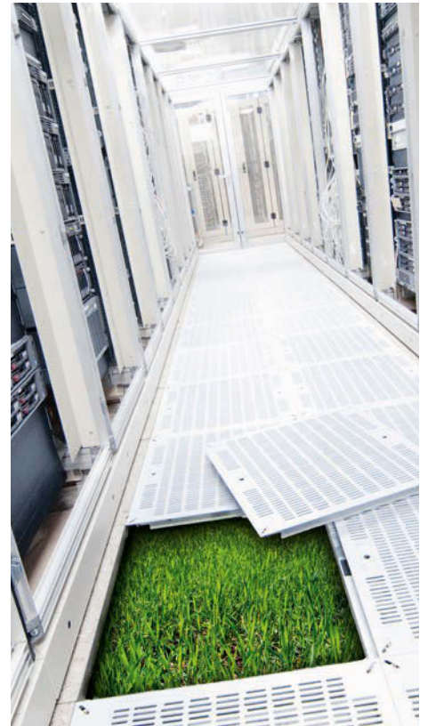
Abb. 19: Grünes Rechenzentrum durch Kaltgang-Einhausung
