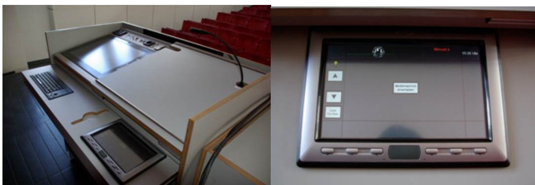
Rednerpult mit Pen-Display, PC-Tastatur und AMX- Mediensteuerung
